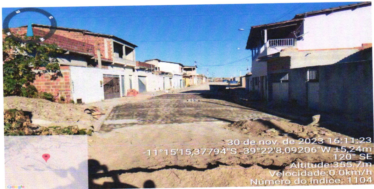
Execução de Pavimentação do Bairro Carolina Rua José Francisco dos Santos
